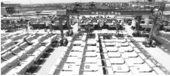
●上海轨道交通17号线节段梁工程。
