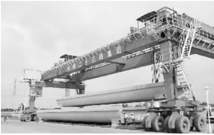
●上海地铁17号线U形梁在提梁。
