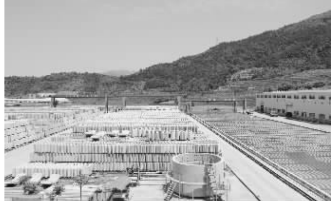
●福州地铁管片生产基地。
