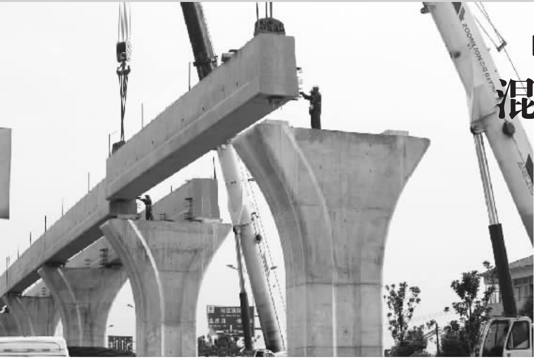
●长沙磁悬浮轨道梁正在架设。
