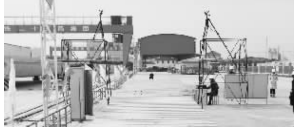
●宁杭客专18号道岔板。
