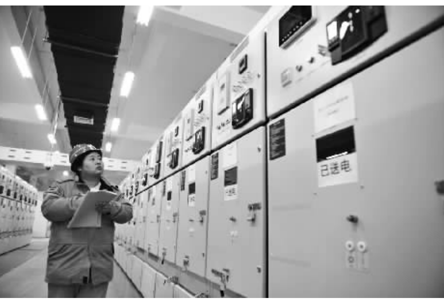
●转岗到潞安煤基清洁能源公司油品加工变电所的许琴,做了一名抄表工,节日坚守岗位。
