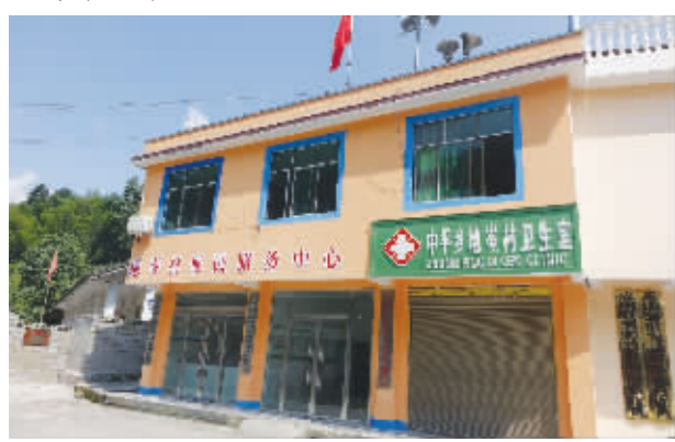
●容溪镇柳水村卫生室
