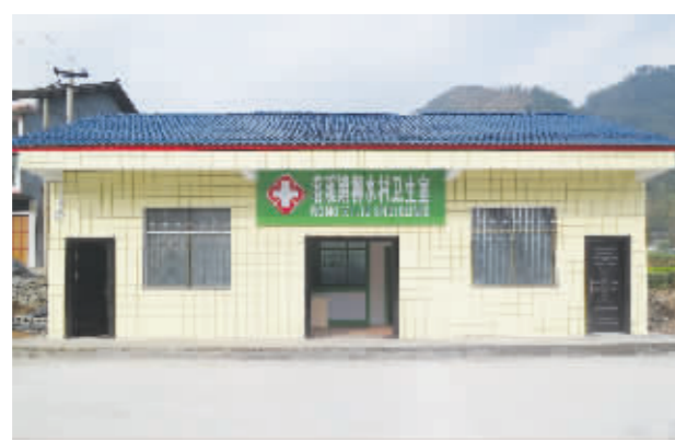
●容溪镇柳水村卫生室
