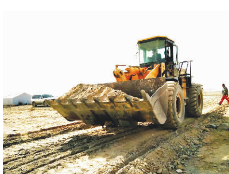
铲车铺填钻井营地通道。(屈永志 摄)
