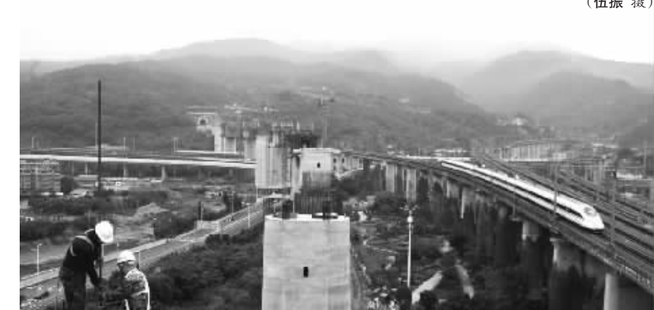
福平铁路闽江特大桥
