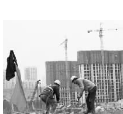
●山西太原，民工在一建筑工地作业。
