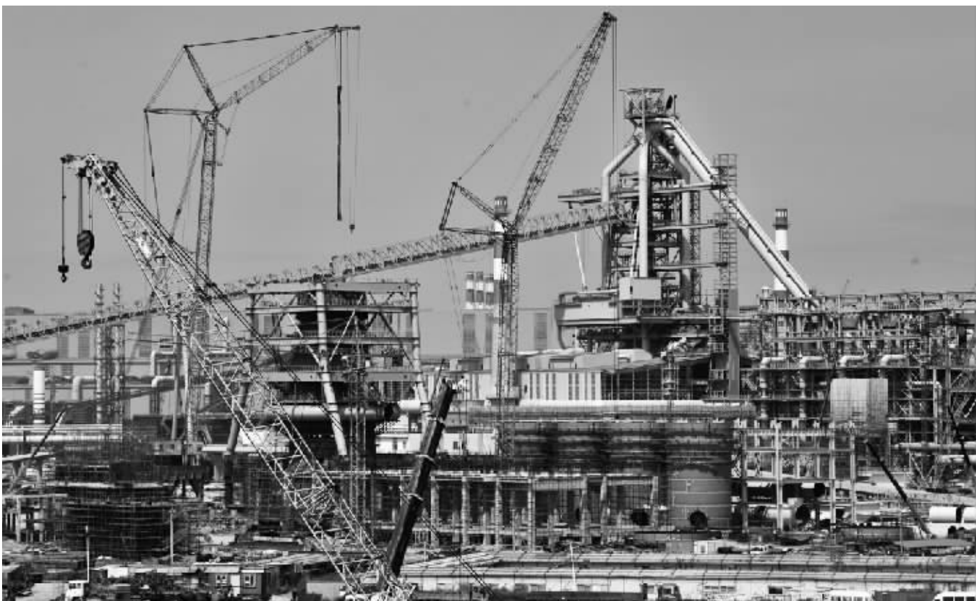
●代表世界最高水平的湛钢高炉工程在建设。
