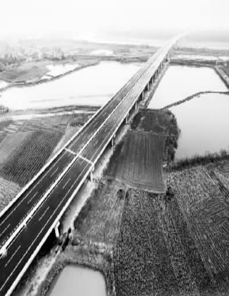
荆江分蓄洪区特大桥工程全貌。
