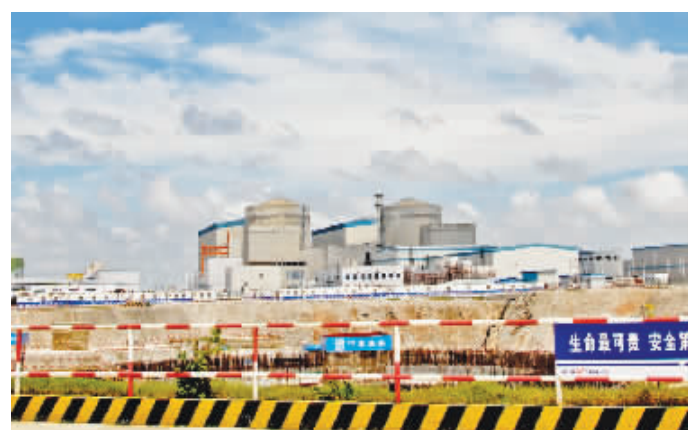
防城港核电站一期工程全面建成
