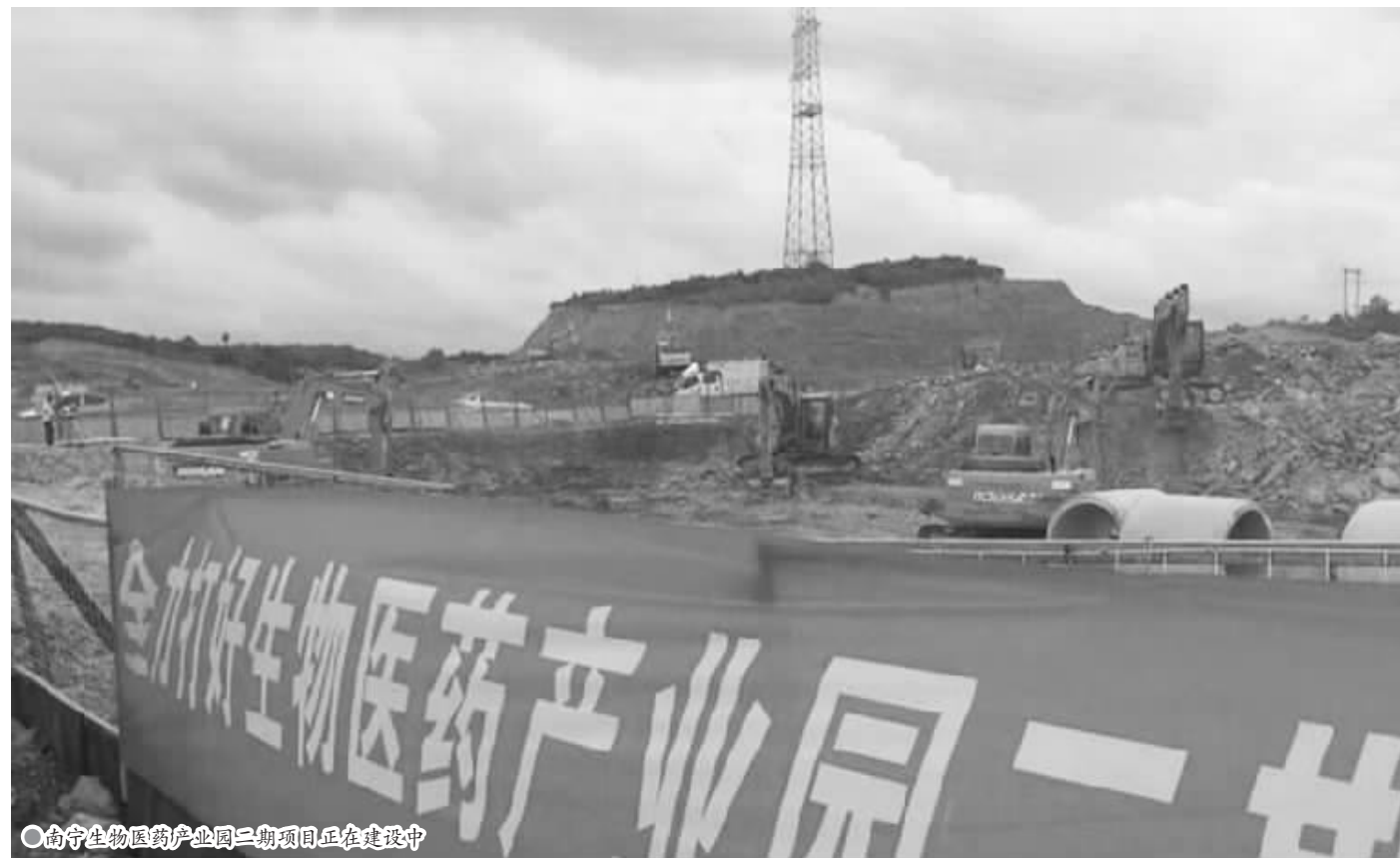
南宁生物医药产业园二期项目正在建设中
