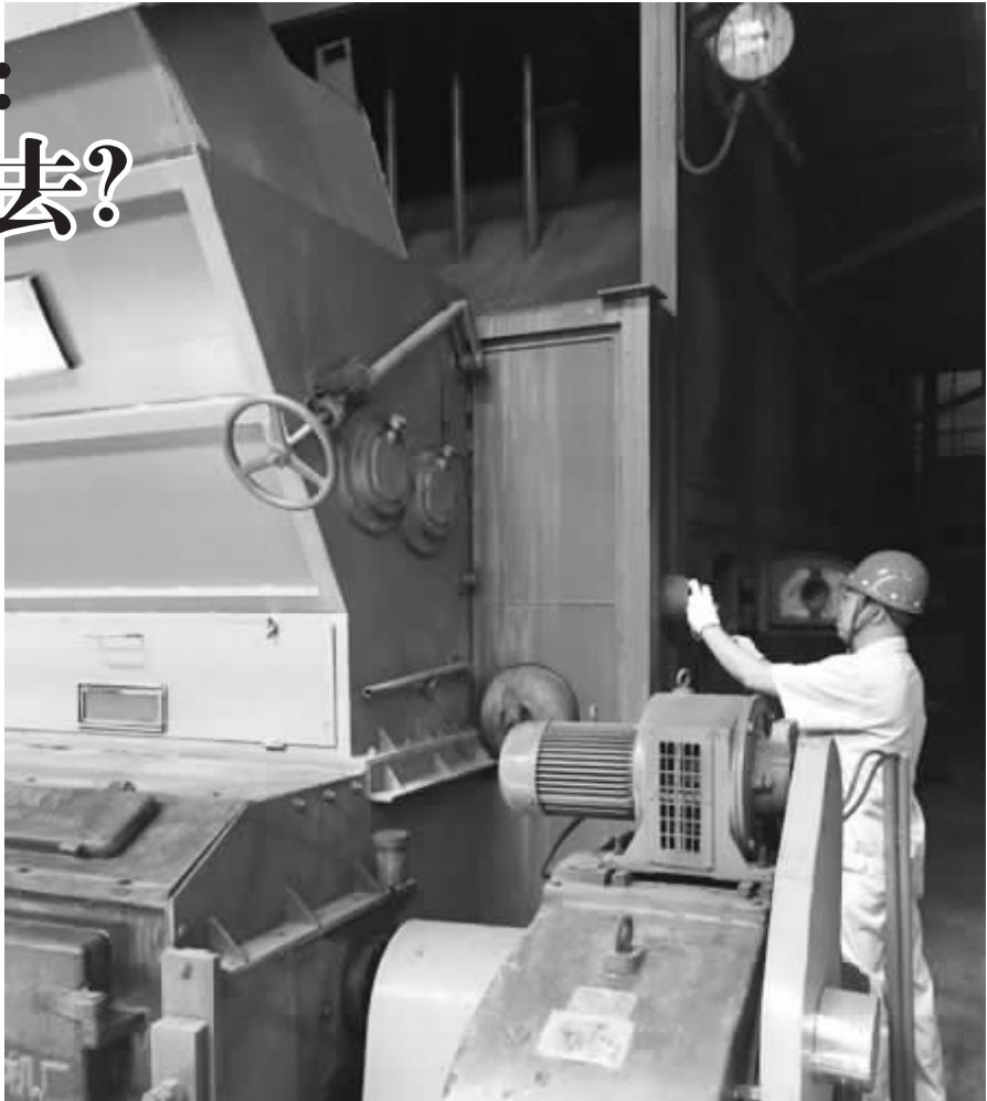
●夏季,鞍钢房产物业公司热力分公司供暖工人正在检修供暖设备。
