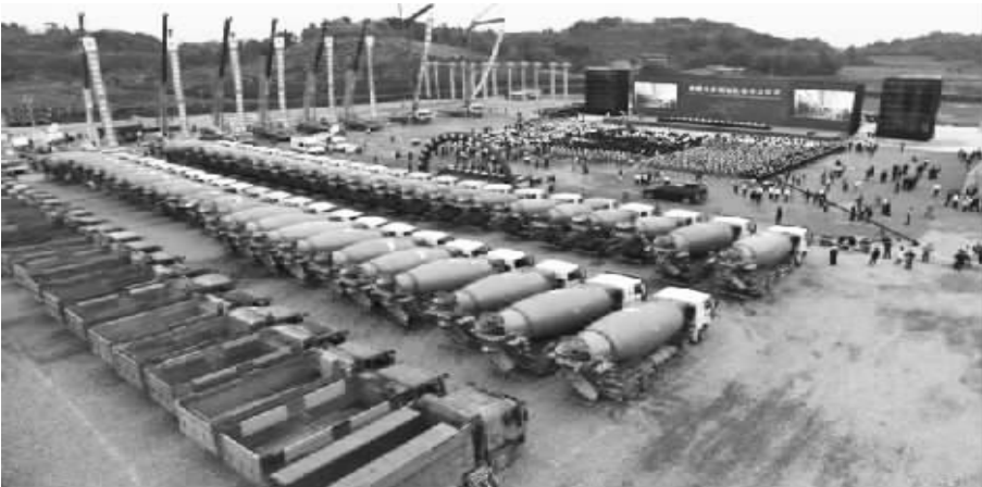
●天府国际机场开工仪式现场
