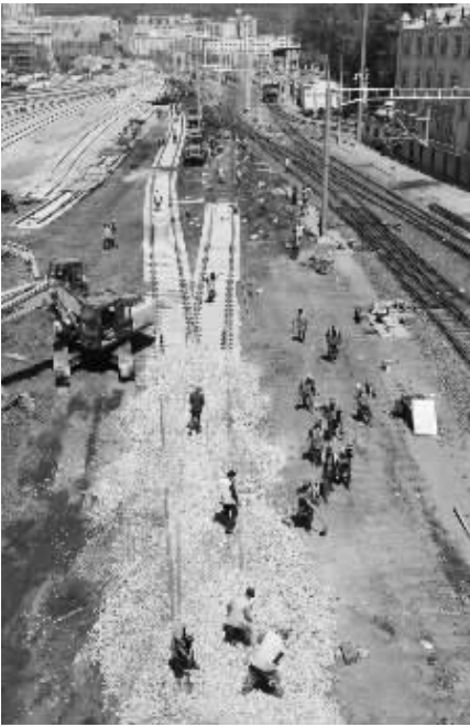
封锁转线施工现场面
