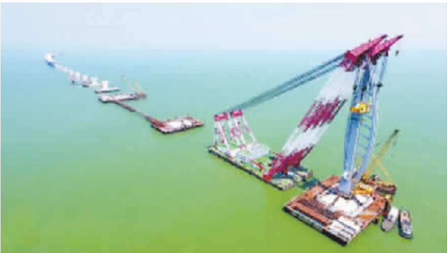
●港珠澳大桥施工
