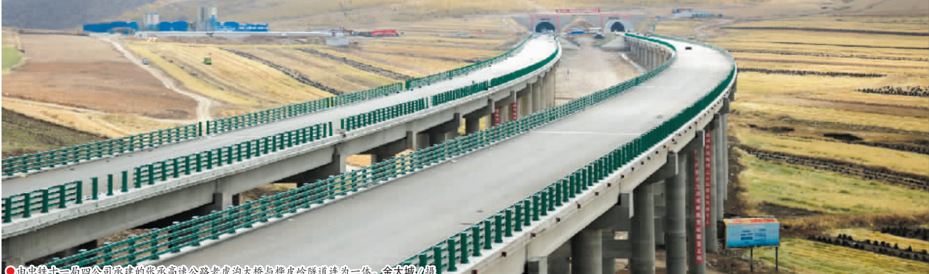
●由中铁十一局四公司承建的张永高速公路老虎沟大桥与桦皮岭隧道连为一体。金大城/摄
