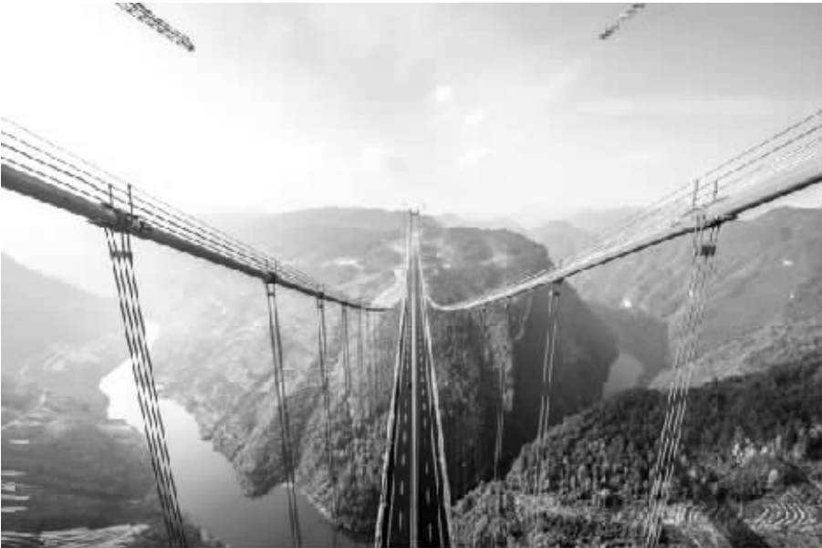
●2015 年 12 月 31 日,贵瓮高速清水河大桥合龙,贵州实现“县县通高速”。傅泊霖 / 摄
