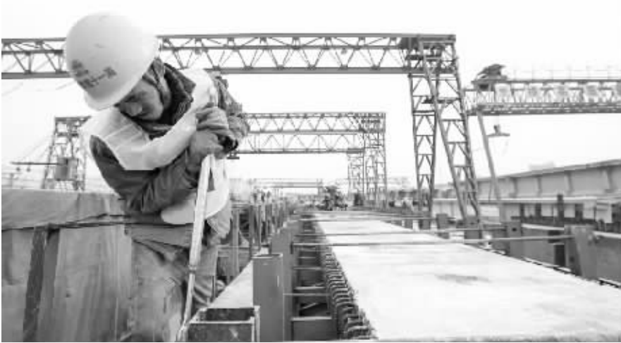
●农民工在张呼铁路制梁场拆解作业(徐云华摄)
