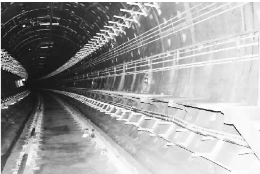
●长沙地铁2号西延线项目环网电缆敷设(吴佳坪摄)
