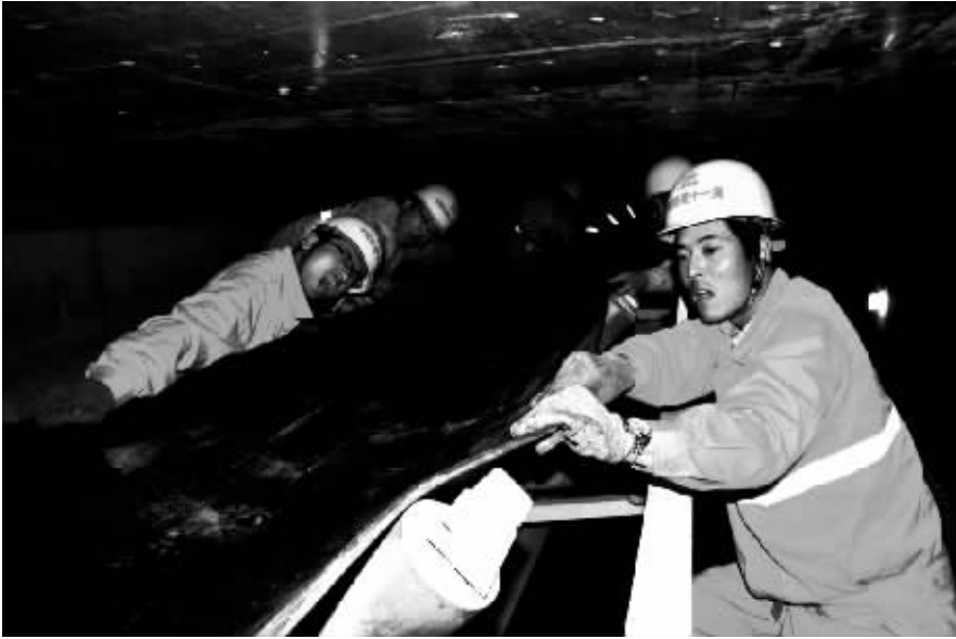
●武汉地铁机场线工程项目盾构工人施工作业(何少亭摄)
