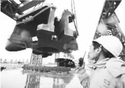
● 图为吊装压机前梁部件 2。 贾磊 摄
