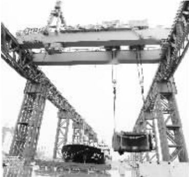
● 图为压机前梁吊装瞬间。 阎展杰 摄
