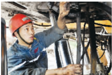
● 图为该矿采煤二队队长胡荣钢正在精心检修综采支架
