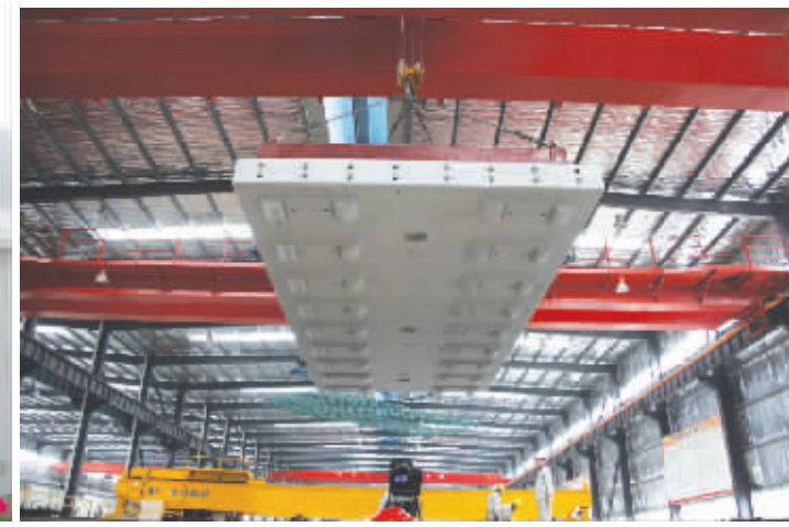
● 高铁 CRTSIII 无砟轨道板起吊。
