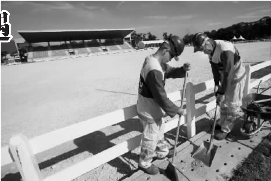
●2016 年里约奥运会奥林匹克公园加紧施工。
