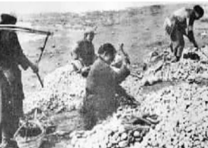
修建机场中捶石头的老妇人
