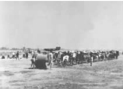
民工们在用石碾碾压新津机场跑道
