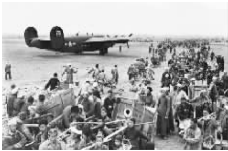
民工们用简陋的工具修筑机场
