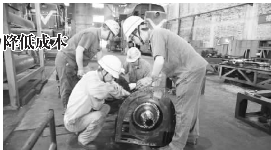
● 图为该公司检修职工精心检修设备时的情景。
