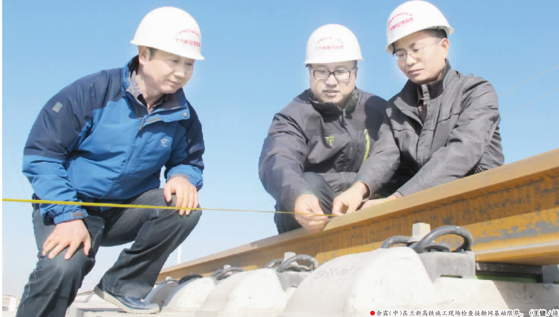
●余霖(中)在兰新高铁施工现场检查接触网基础限界。(王健/摄)
