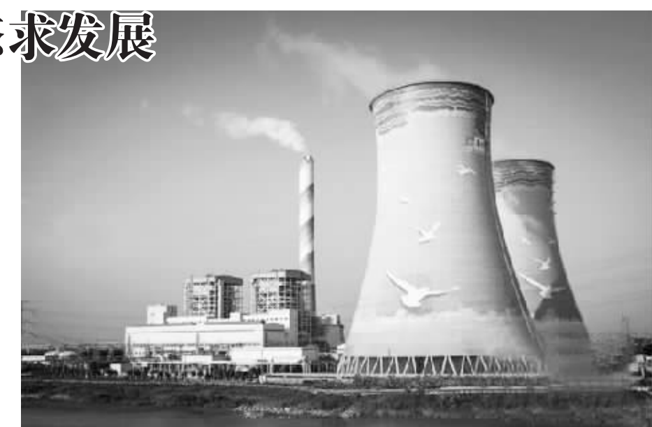
位于广州市南沙区的广州华润热电厂。
