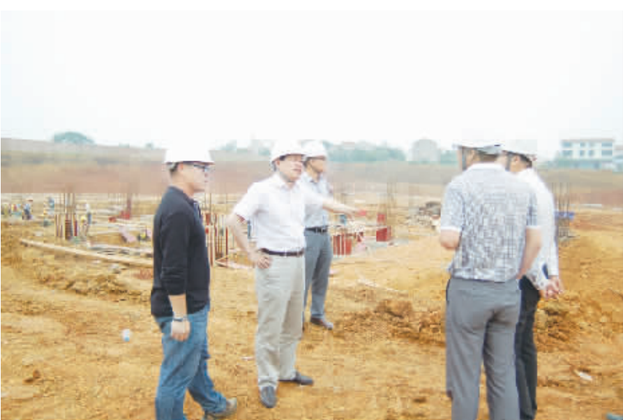
●唐清明(左2)到武汉地铁机场线BT二工区调研施工进度情况(肖帆...)
