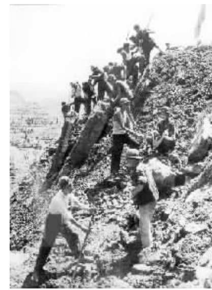
民兵艰难施工
