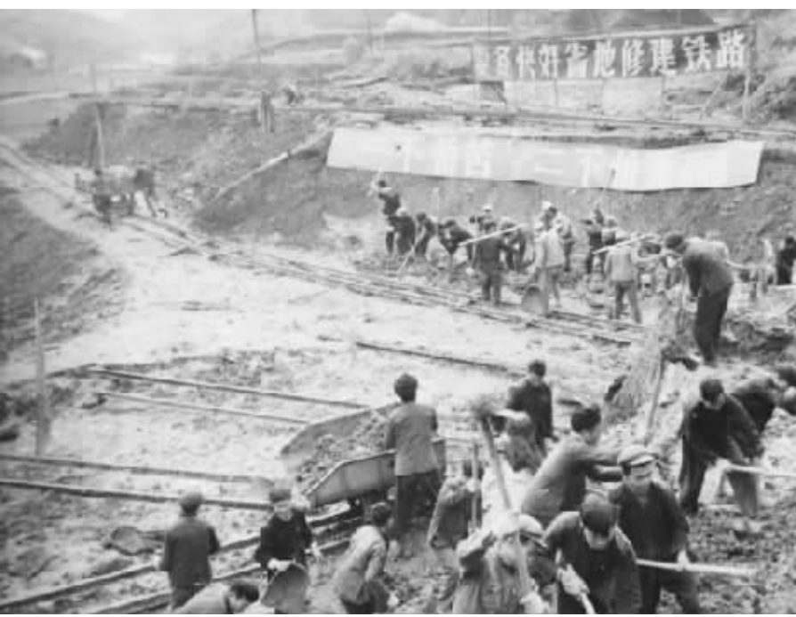
上世纪70年代,湘黔铁路三穗团施工现场
