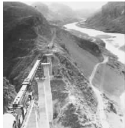
架桥机在架设混凝土T梁
