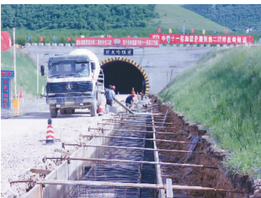
张承项目防雪棚基础施工(张贤涛摄)
