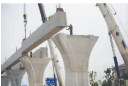
●架梁施工,精准定位。
