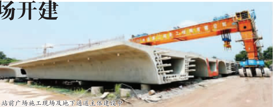
站前广场施工现场及地下通道主体建设中
