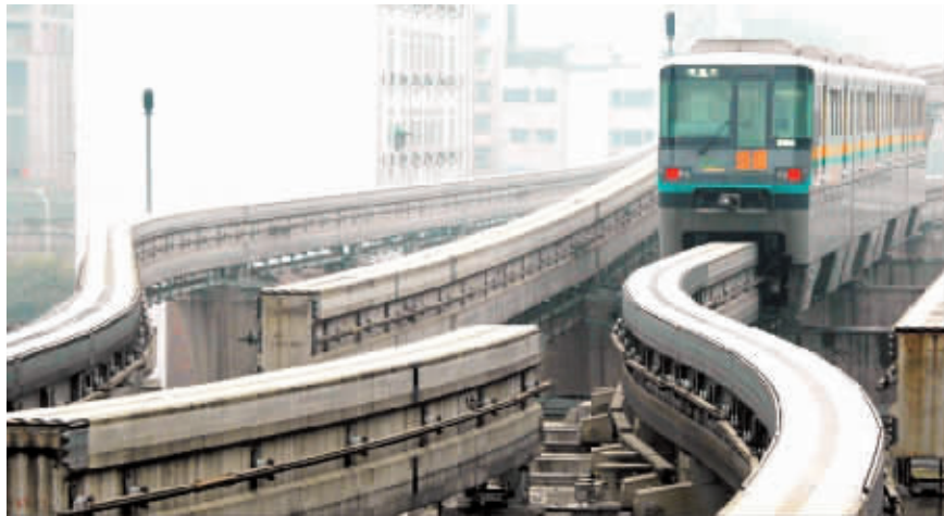
● 中铁二十三局研制施工的重庆轨道交通 PC 梁 75 米最小曲线半径技术目前仍处于世界领先地位。
