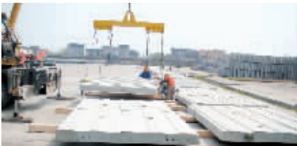
● 国内首次应用的沪杭客专 42 号无砟道岔板由中铁二十三局研制。
