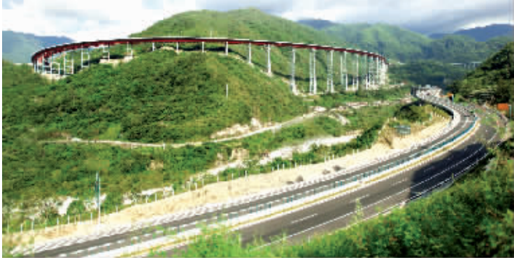
● 中铁二十三局担负施工的雅西高速干海子特大桥 马鹏飞 / 摄影
