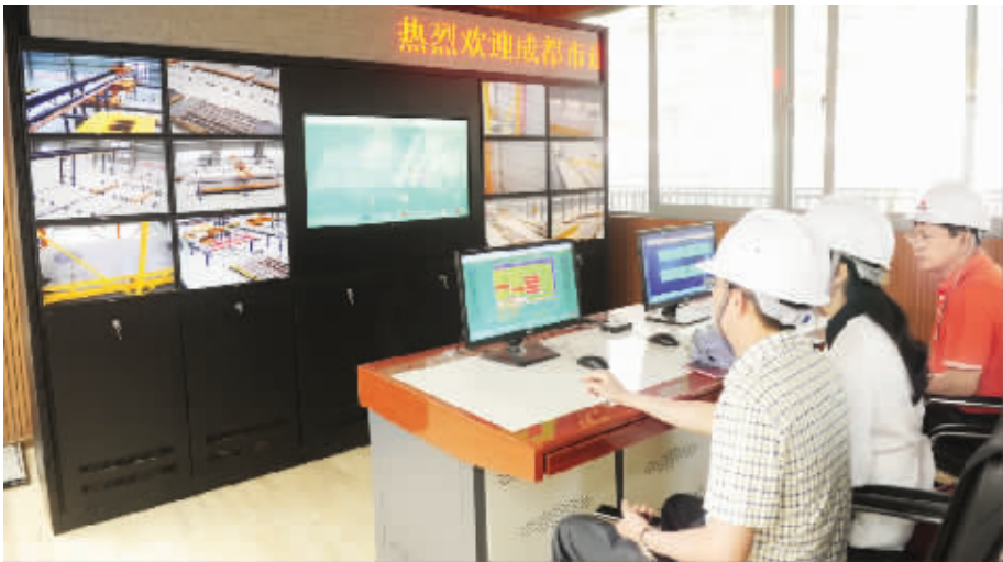
● 成都建工建筑工业化生产线控制室
