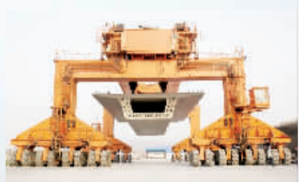
● 大吨位提梁机作业
