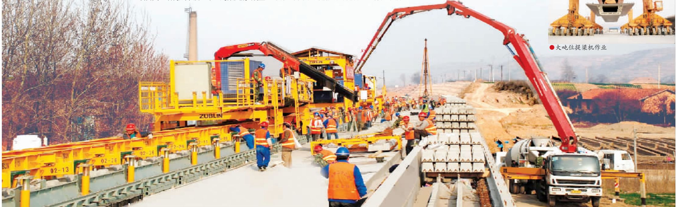
● 无砟轨道施工现场
