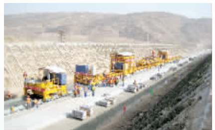
● 高铁现场施工作业
