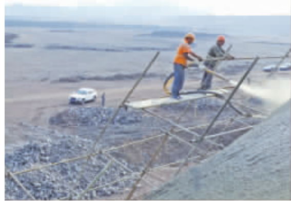
烈日下,工人正在进行锚喷作业
