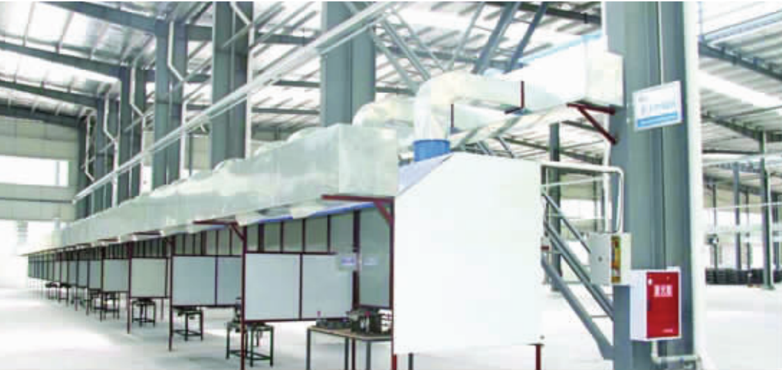
● 图为手工焊接区
