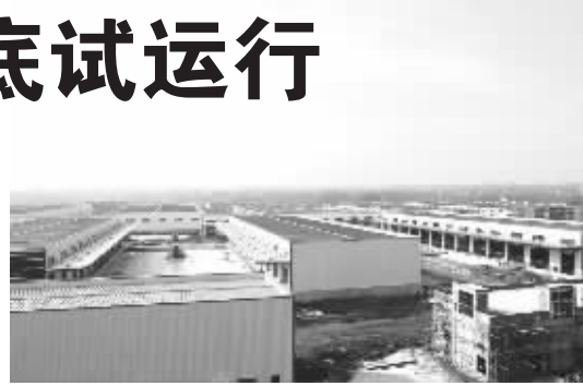
● 正在加紧施工南充快递产业园
