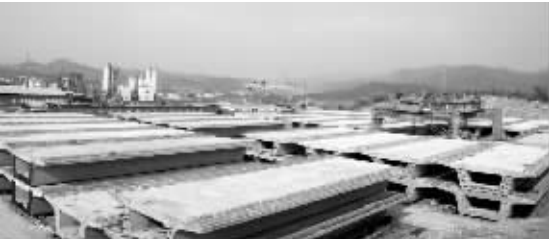
●沪昆项目(担负沪昆客运专线34座大桥427孔箱梁的预制任务,辖乌当和贵定两个梁场,其中乌当梁场247孔梁、贵定梁场180孔梁,图为乌当梁场鸟瞰)
