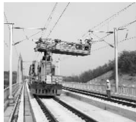
●沪昆高铁湖南段湘潭北至韶山南区间的接触网施工作业。但汉求 摄
