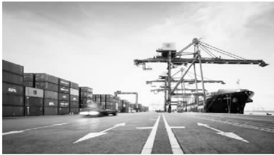
●SOHAR港口一角。
