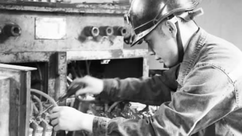
● 图为甘海洋在检修机电设备。
