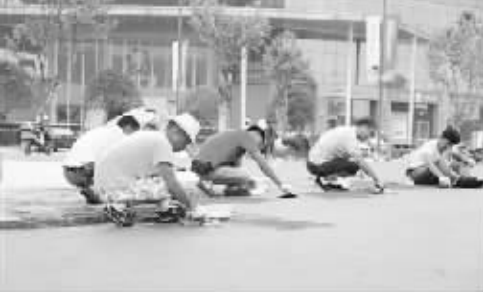
●工人铺设自驾游营地橡胶场地
