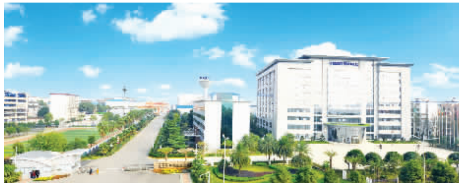
●特变电工衡阳变压器有限公司全景
