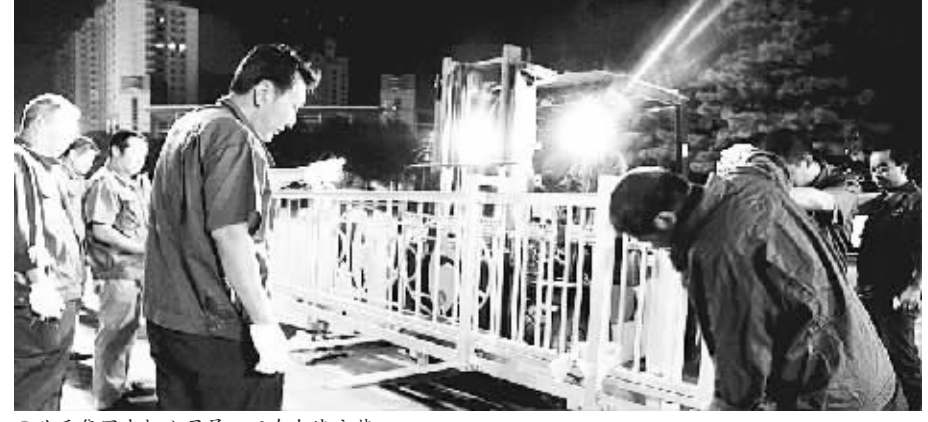
●北重集团专机公司员工正在奋战安装。
