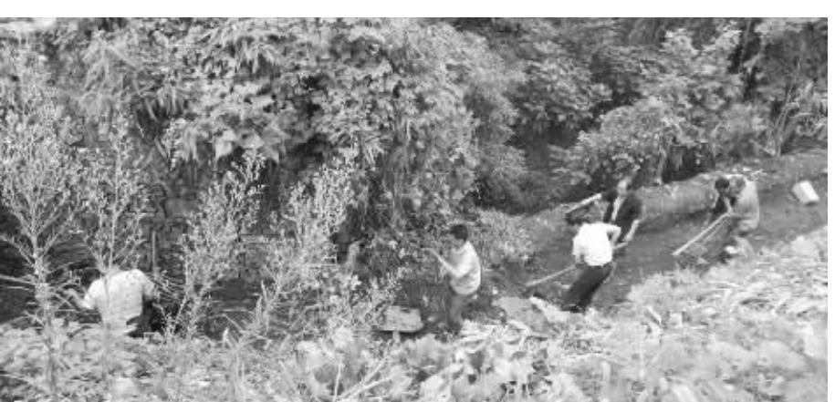
● 党员义工疏通水沟
