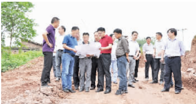
● 沈军在工业园区 2 号路项目现场督查。
