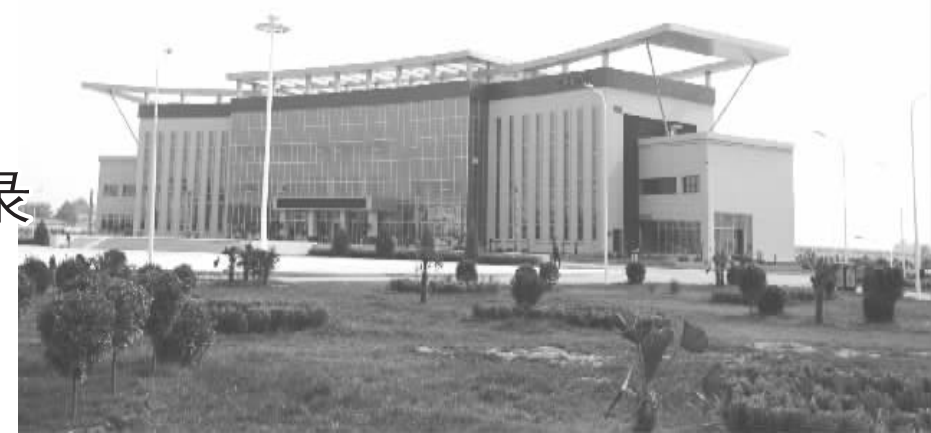
2013年建成并投入运行的芮城工业园区
