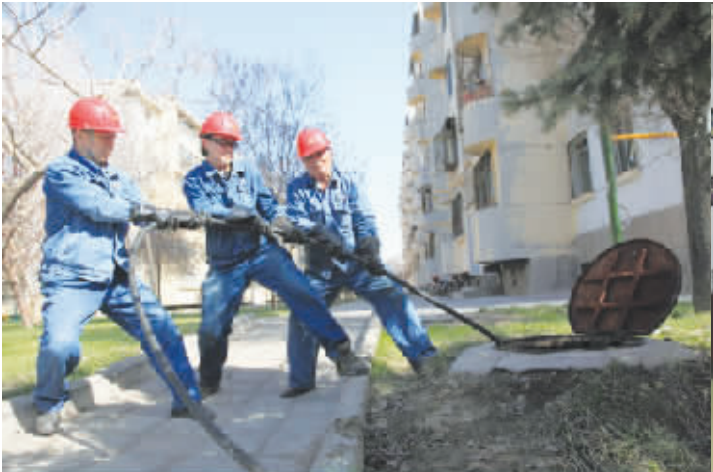
●4 月 17 日，下水道班在进行外井清淤作业。
