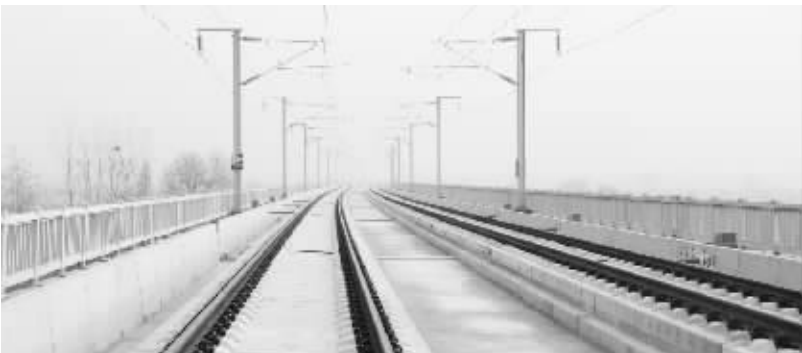
●武黄城际铁路接触网全线一次送电成功 秦钊/摄
