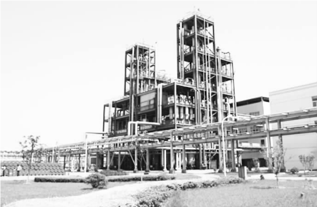
●中化集团所属四家企业的工程建设项目获得“2012—2013 年度国家优质投资项目奖”。图为中化太仓环保 134a 项目(图片来源:中国中化集团网站)
