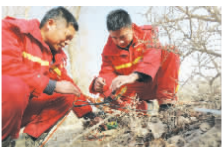
●工地现场排故障
