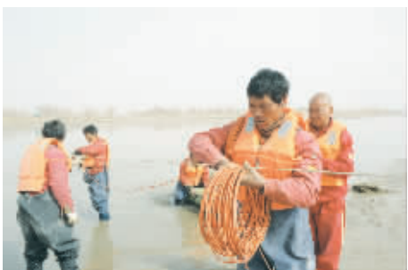
●架线作业塔里木河
