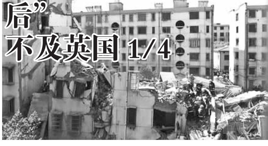
应该采用钢筋和水泥的地方或减少或取消,甚至以泥浆代替水泥砂浆使用,也会严重影响房屋质量和使用寿命。
